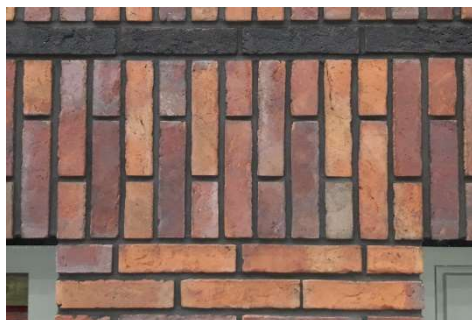
Horizontale onderbreking verticaal metselwerkverband
